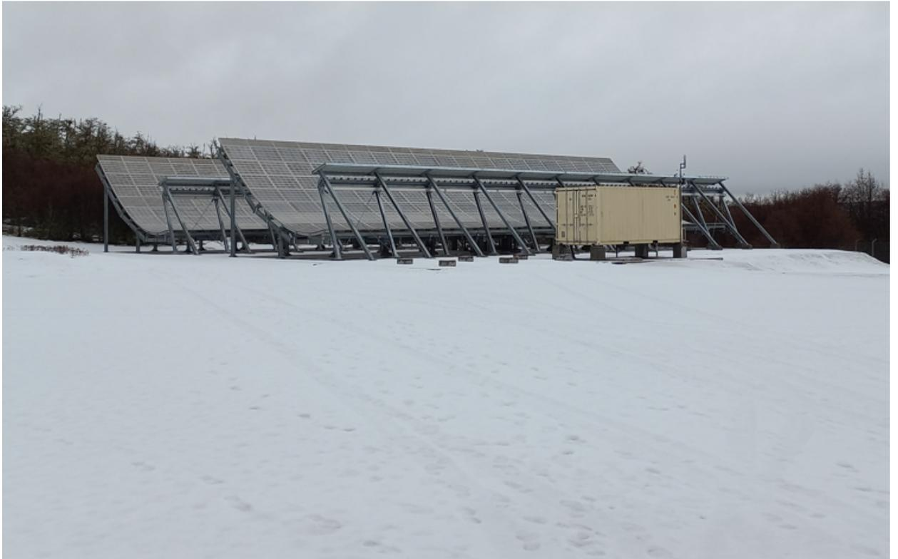
Cada elemento ilumina un reflector de gran apertura, contando de 512 antenas individuales sin ningún movimiento mecánico, operando en Banda S (2910 -2990 MHz), una potencia de transmisión máxima de 100 W con un ciclo de trabajo de 20%, correspondiente a una potencia pico de 51,2 kW y una potencia media de 10,24 kW.
